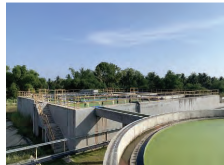
ภาพที่ 2-7 บ่อเติมอากาศ
