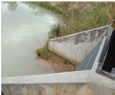
ภาพที่ 2-11 ประตูระบายน้ำและอาคารสลายพลังงาน (Stilling Basin)
