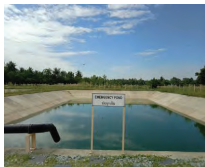
ภาพที่ 2-10 บ่อพักน้ำทิ้งฉุกเฉิน ระบบบำบัดน้ำเสียส่วนกลางของนิคมฯ
