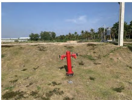
ภาพที่ 2-26 หัวจ่ายน้ำดับเพลิง ตามแผนของพื้นที่โครงการ
