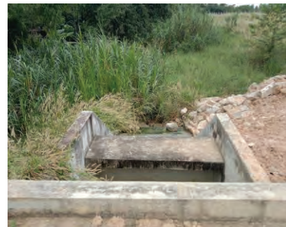
ภาพที่ 2-11 ประตูระบายน้ำและอาคารสลายพลังงาน (Stilling Basin)
