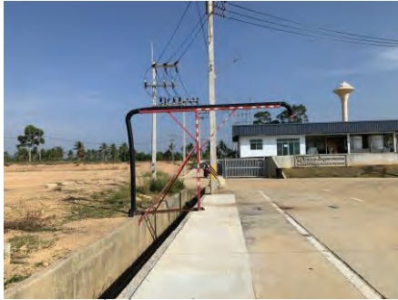
ภาพที่ 2-4 จุดรับน้ำทิ้งภายหลังการบำบัดแล้วไปรดน้ำต้นไม้ ภายในนิคมฯ
